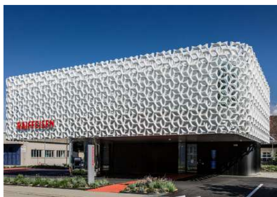
Hình 1. Raiffeisen Bank (Thụy Sĩ) được trang trí mặt tiền bằng các chi tiết từ UHPC.
