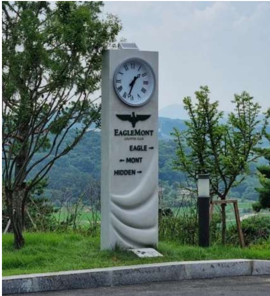
Hình 5. Cột đồng hồ tại sân golf Eaglemont, Úc bằng UHPC sử dụng sợi POM.
